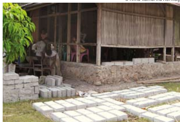
Der sicherste Schutz vor Überschwemmungen ist ein Haus aus Stein und Zement, wie dieses von Pak Alexander und Ibu Johanna. Den Bau können allerdings nur besser verdienende Einwohner finanzieren
