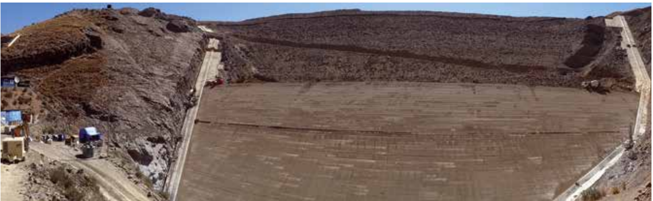
Panorámica del Proyecto Misicuni en 2015 (Foto: M. Azero) / Panoramic view of the Misicuni project in 2015 (Photo M. Azero)
