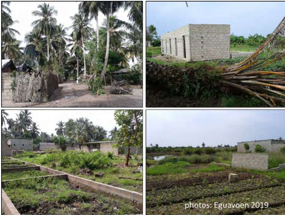
Image 9 Secteur d'Anoumakro, bornes et chantiers
